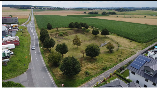
Abb. 7: Regenrückhaltebecken und Burg-Gräfenröder-Straße
